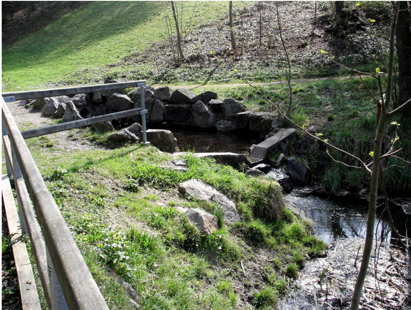
Der Zulauf mit dem Sandfang
