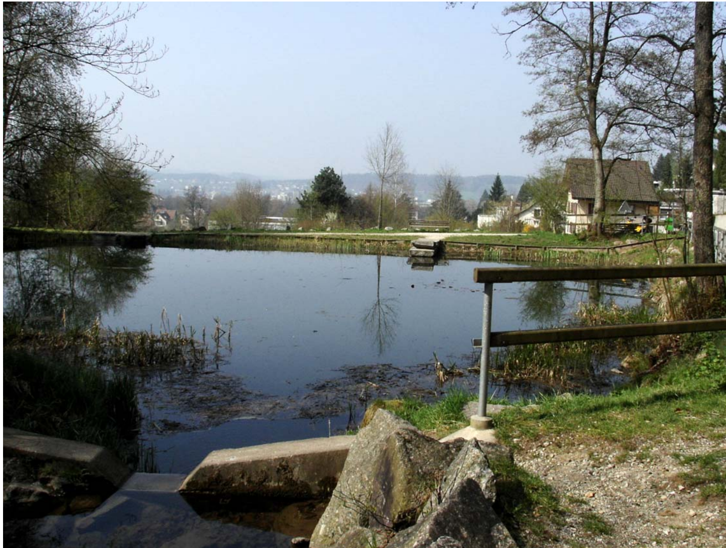
Blick vom Zulauf Richtung Auslauf und Stadt (Richtung Westen).
