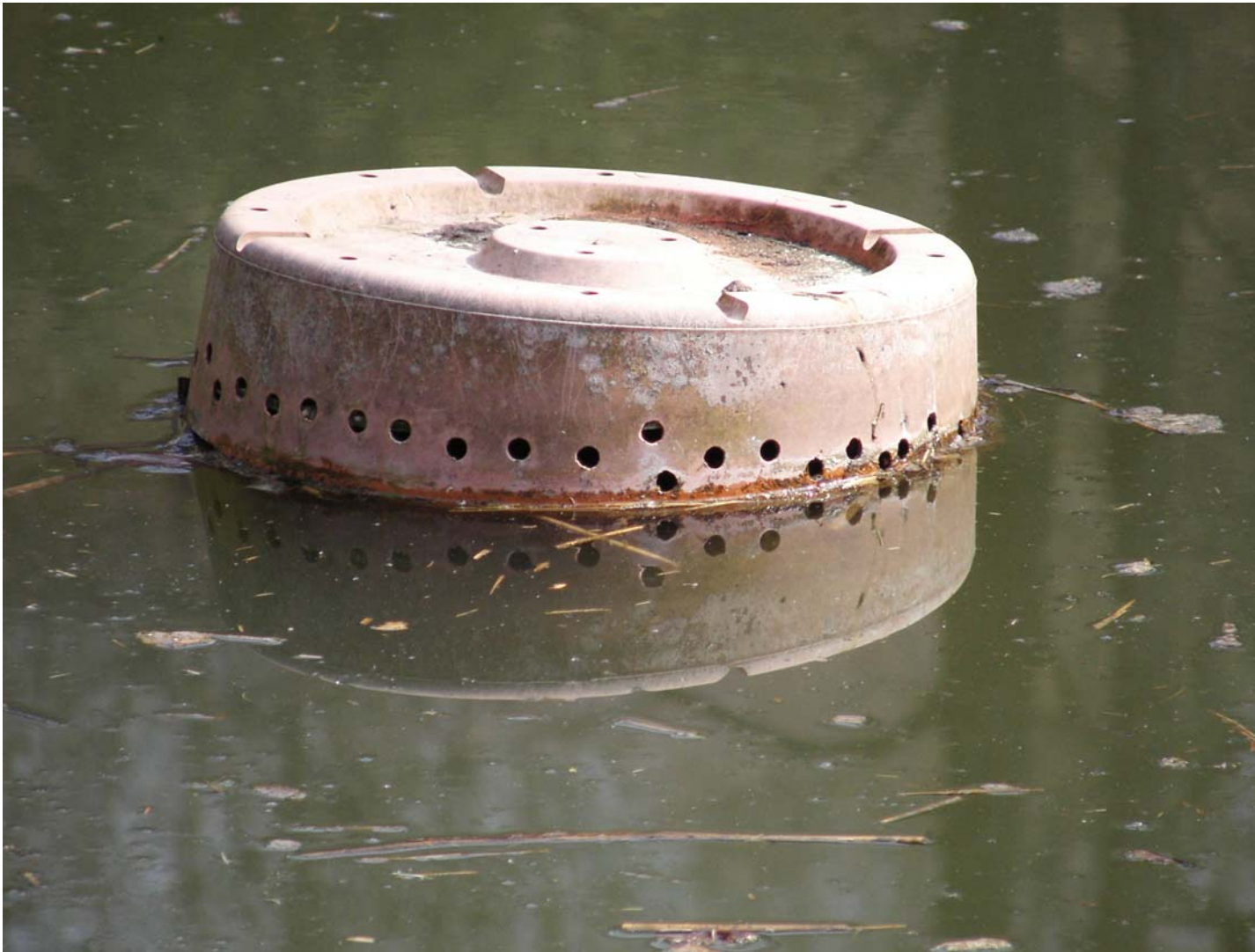
Der Auslauf mit dem Schutzdeckel, der das Ansaugen von Amphibien verhindert.
